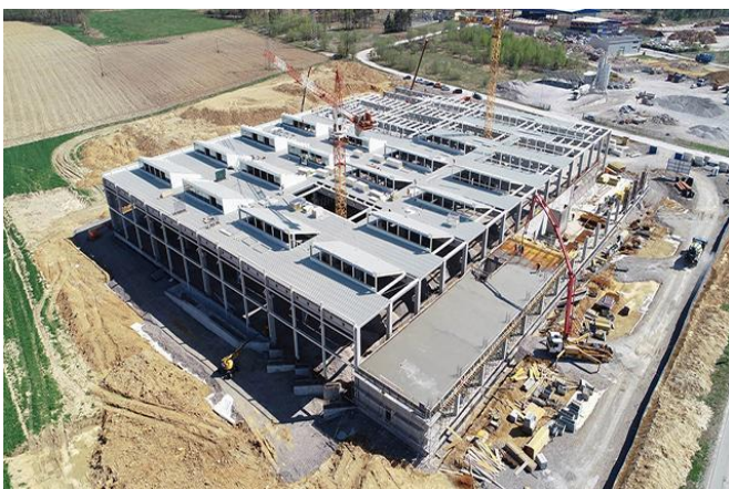
(写真：工事が進む安川ヨーロッパ社の新規ロボット製造拠点、Moja Dolenjska)
